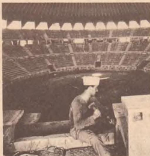
Il Palazzo dello Sport in costruzione
