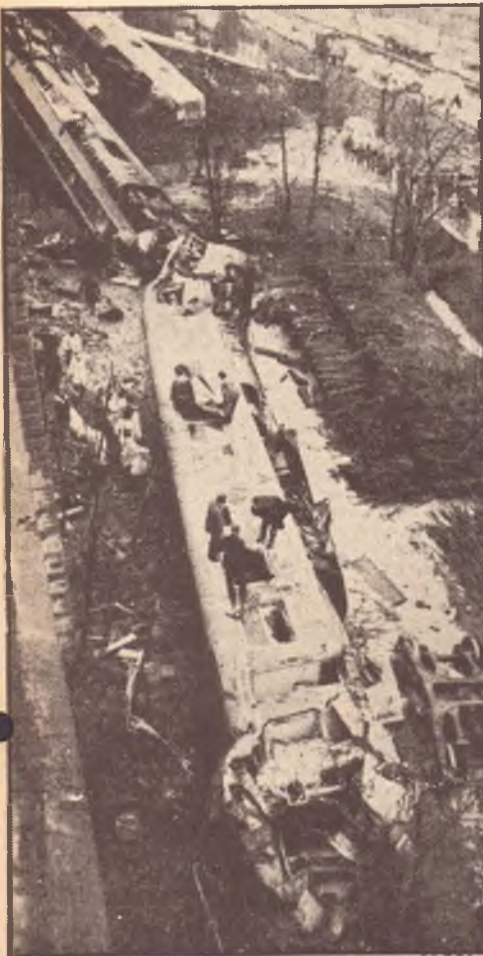
BOLOGNA — Il luogo del disastro visto dall'alto con i vagoni nella scarpata
