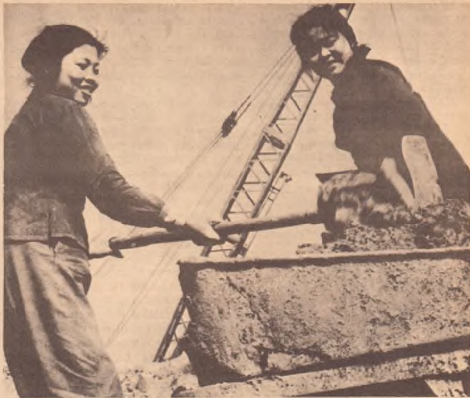
Ragazze di Hanoi lavorano in un cantiere.
