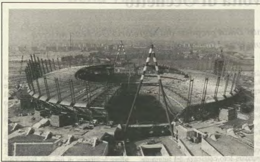
Lavori in corso allo stadio comunale di Torino (foto Ansa)
